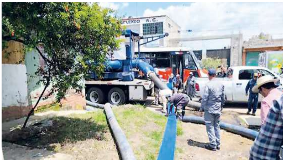
Mantiene Conagua las labores de desazolve y desalojo de agua anegada en el municipio de Chalco.
